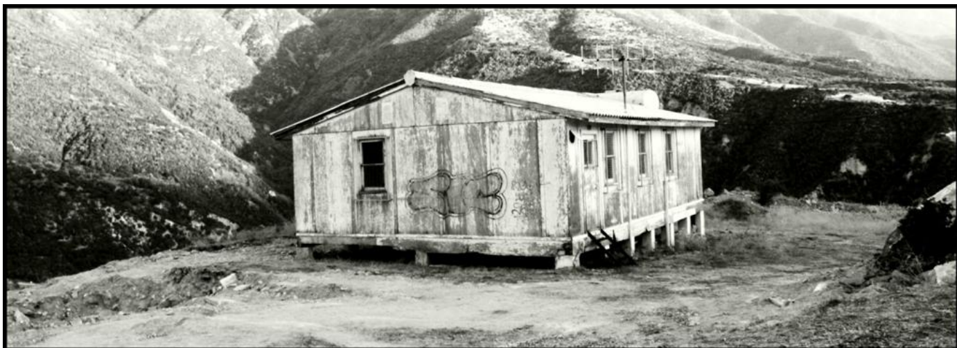
Έλενα Εφέογλου, Εγκαταστάσεις ΔΕΗ ΑΕ, φράγμα Πολυφύτου, 2013
